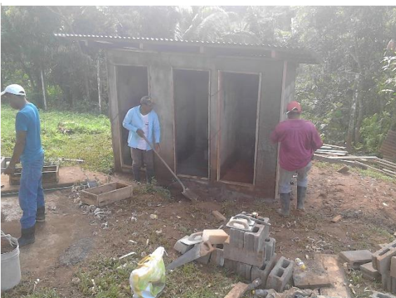
Construcción de Batería de Inodoros. El Tortuguero
